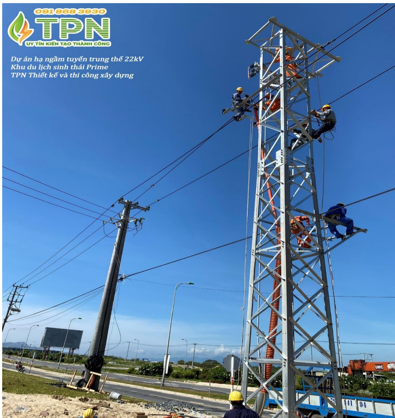
Dự án hạ ngầm tuyến trung thế 22kV - Khu du lịch sinh thái Prime
